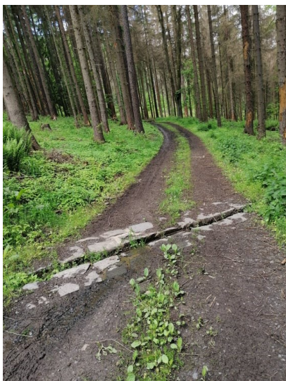
Obr. 1. Ukázka příčného odvodnění z lomového kamene
